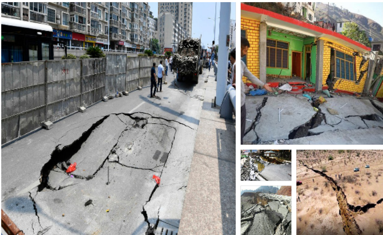
شکل ۳. خرابی‌های ناشی از پدیده فرونشست
