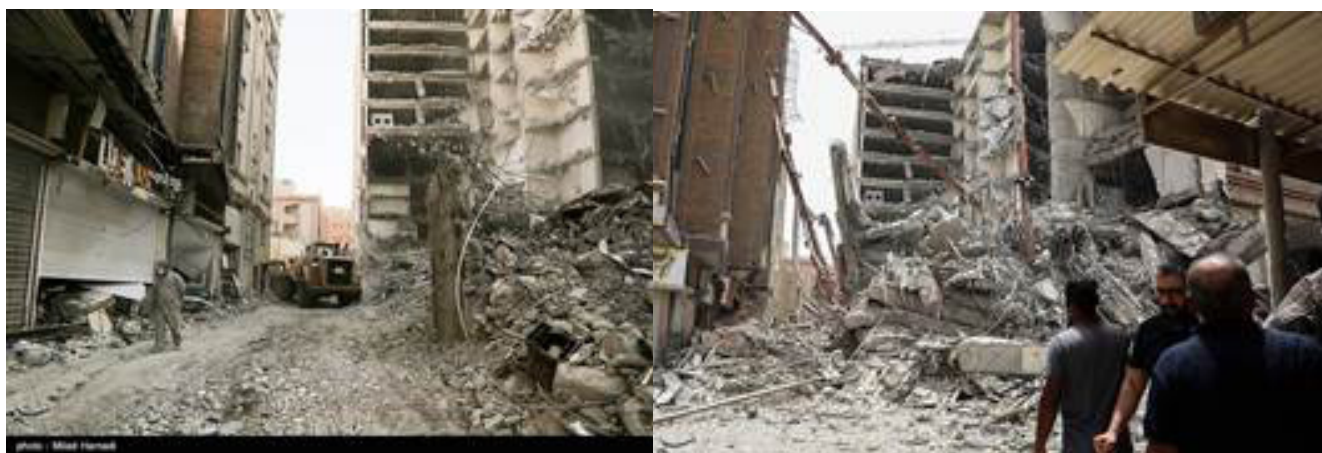
تصویر ۴. آوار سنگین ساختمان فرو ریخته متروپل در بافت فشرده شهری
