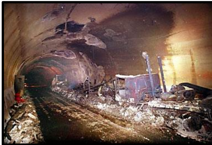
شکل ۱. عکسی از آوار باقی‌مانده بعد از پایان آتش‌سوزی در تونل مون‌بلان
