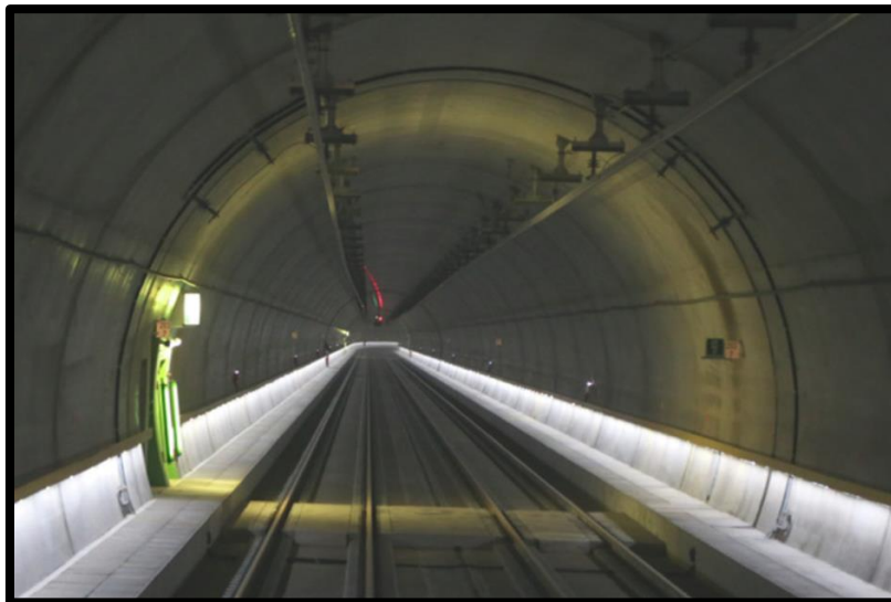
شکل ۷. یک تونل ریلی دو مسیره مجهز به دو پیاده‌راه در دو سمت تونل
