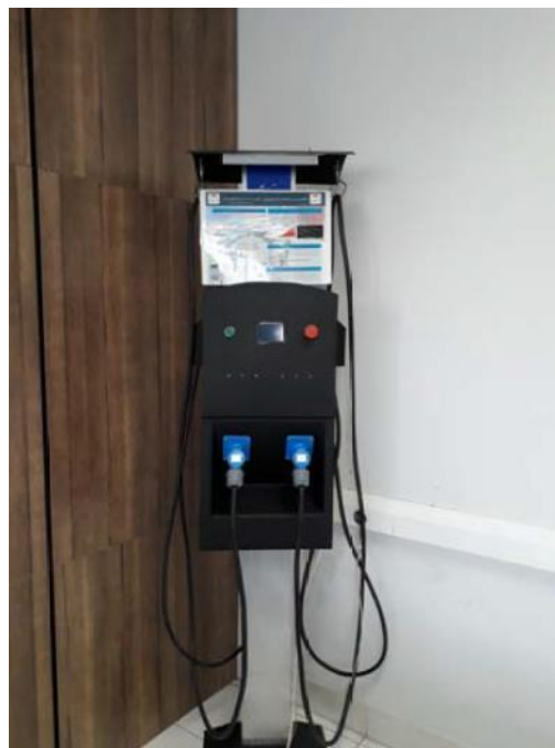
شکل ۱. نمایی از ایستگاه شارژ دیواری ساخته شده در پژوهشگاه نیرو
