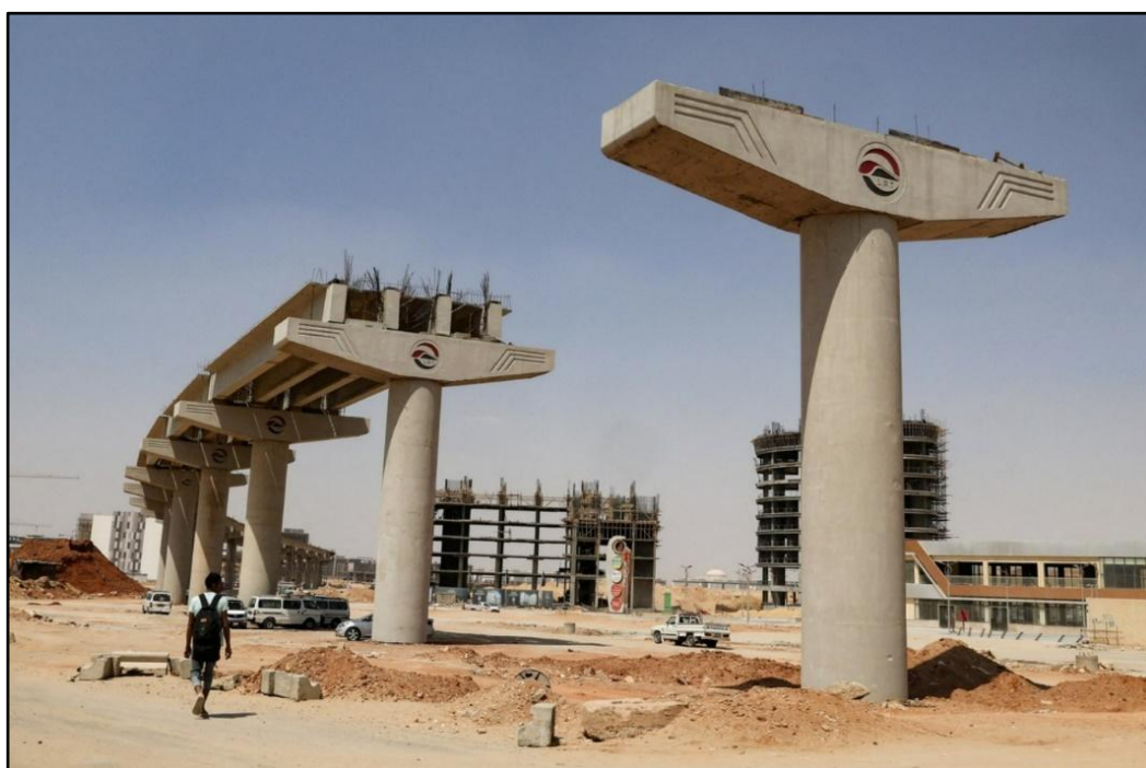
شکل ۱۴. عملیات عمرانی ساخت یک خط آهن سبک (LRT) جدید در پایتخت اداری جدید [۴۳]
