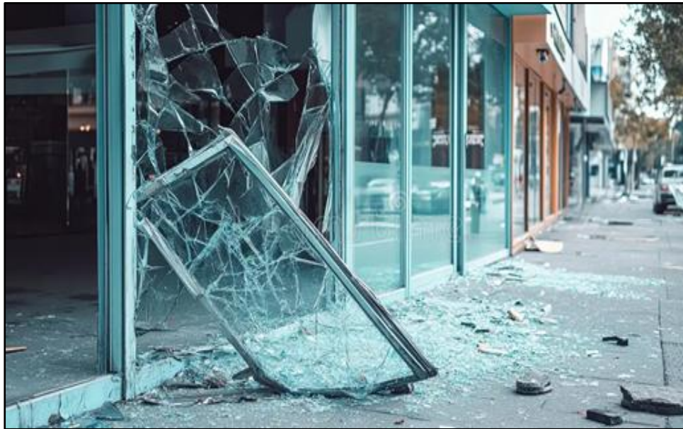
شکل ۲۰. شیشه‌ویترین کامل شکسته و در کف ریزش کرده - نشان‌دهنده خطر جدی در صورت استفاده از شیشه معمولی (نه لمینیت) [۴۳]
