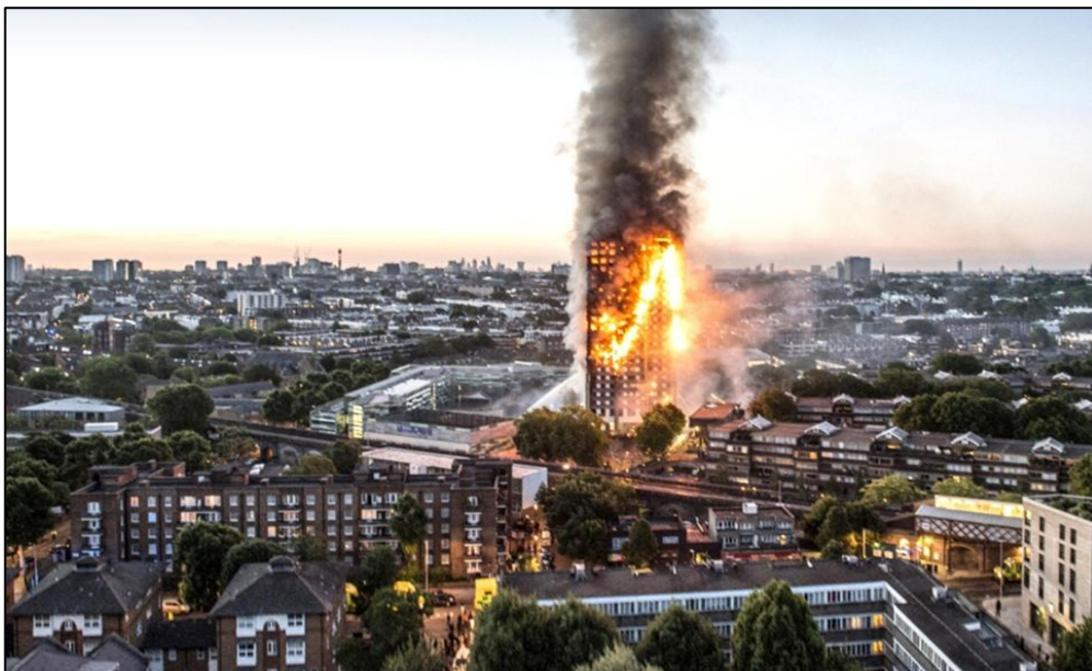
شکل ۲. آتش‌سوزی در برج گرنفل (Grenfell Tower) در لندن (۲۰۱۷) [۲۹]
