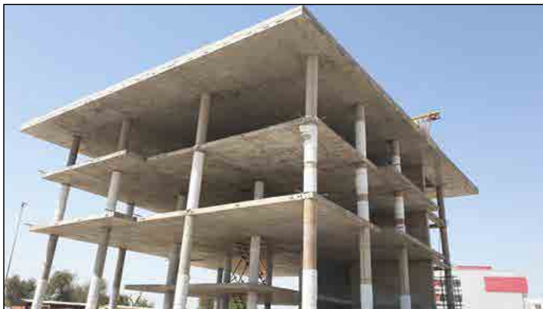
شکل ۷. سقف پیش‌تنیده که می‌تواند رفتار ترد و شکننده‌ای در برابر بارهای دینامیک داشته باشند [۳۳]
