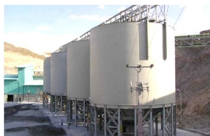
شکل ۴. الف) سد آبگیر (قرمز) و رسوب‌گیر (زرد)، ب) تیکنرهای مخروط عمیق مس میدوک [۲۵]
