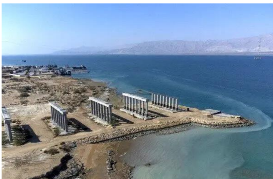
شکل ۸. پایه‌های نیمه‌کاره پل خلیج فارس در قسمت خشکی
