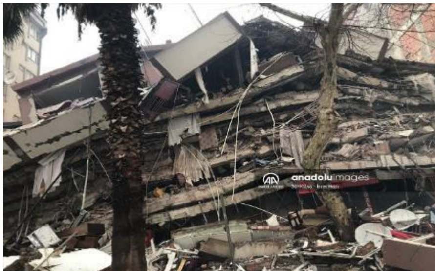
تخریب ساختمان‌های با سقف دال تخت
