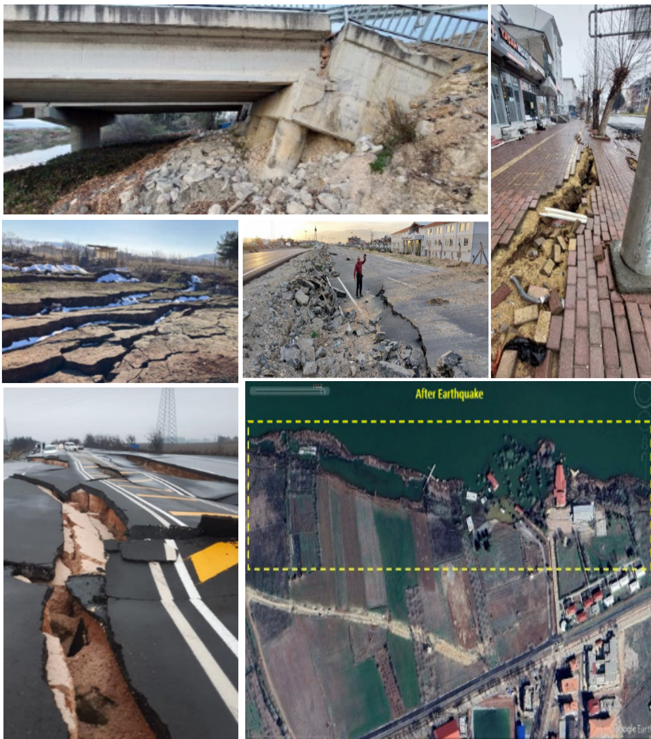
شکل ۷. آثار روان‌گرایی و گسترش جانبی در زلزله ترکیه [۱۹]
