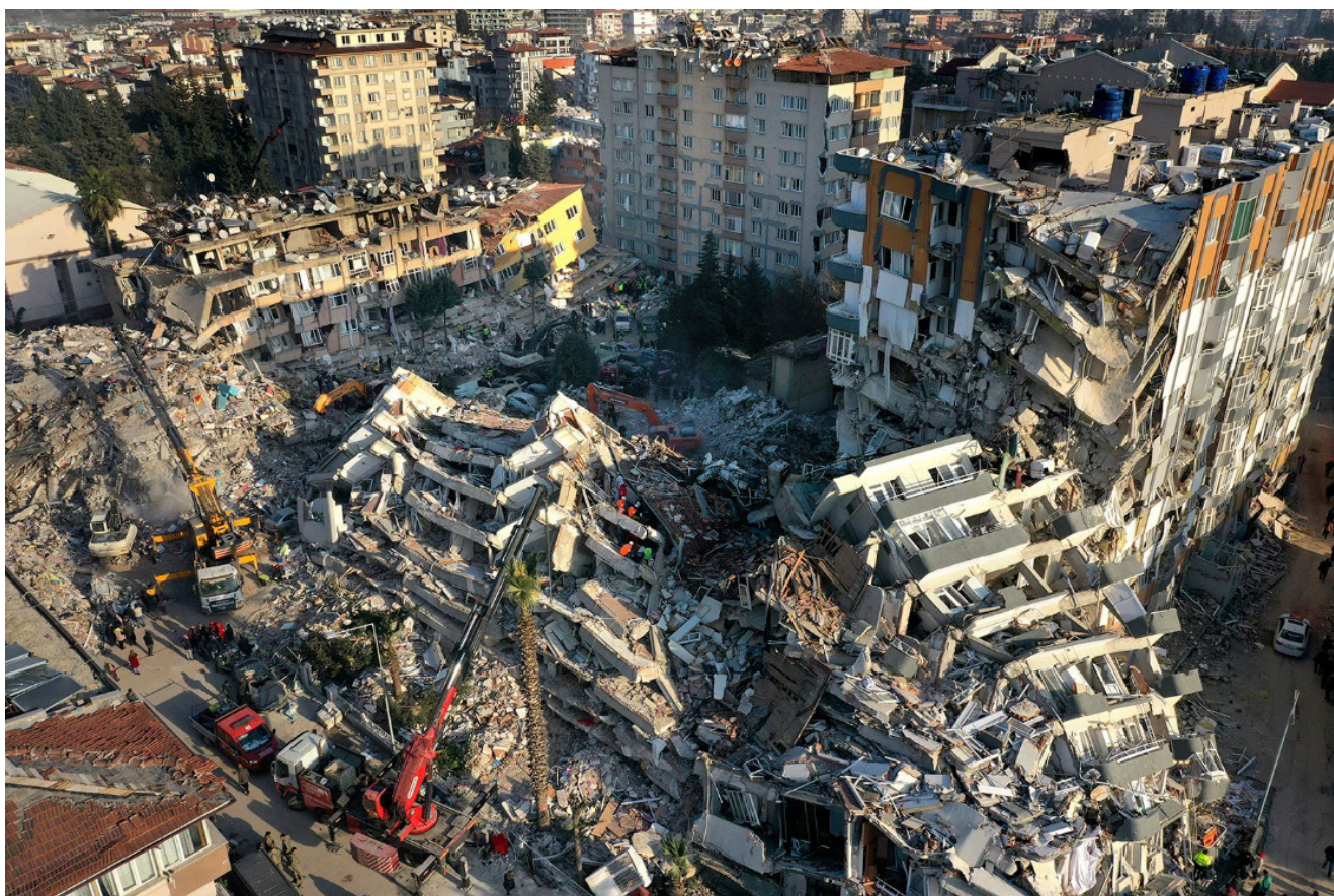
شکل ۱۰. واژگونی سراسری ساختمان‌ها
