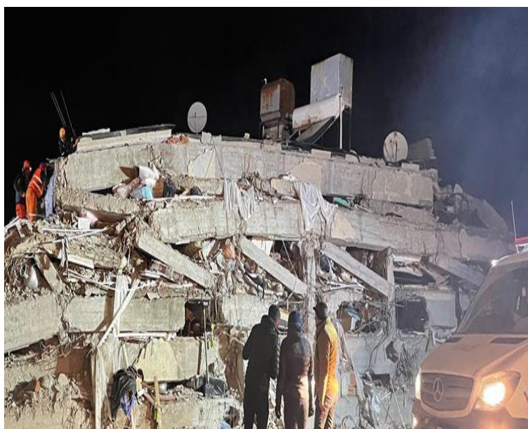
تخریب کامل ساختمان (فرم پنکیک)
