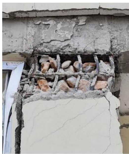
کیفیت نامناسب بتن و شکست ستون
